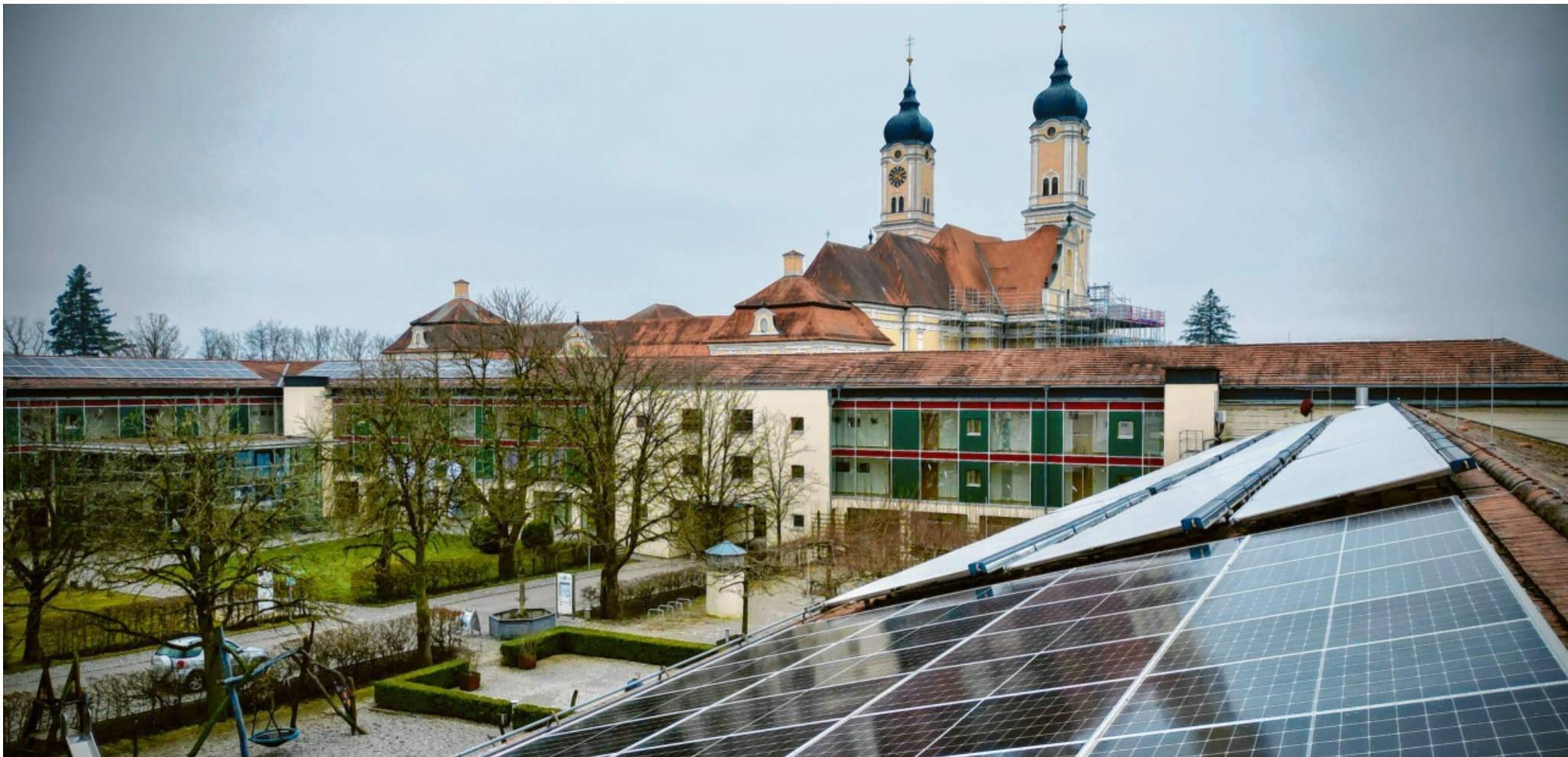
Ein Anfang: Beim Kloster Roggenburg läuft seit Kurzem eine Fotovoltaikanlage, Bürgergenossenschaften sehen im Kreis Neu-Ulm und Ulm aber weit mehr Potenzial für erneuerbare Energie. Foto: Alexander Kaya
