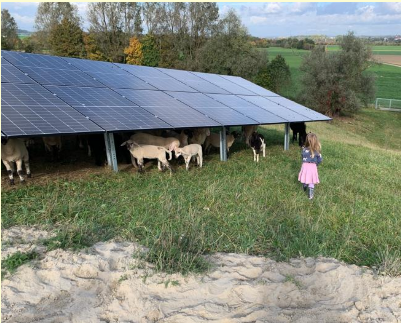
Freiflächenanlage auf ehemaliger Deponie mit Schafbeweidung, Biodiversität (Eidechsenhabitat) Bildquelle: Energiewerk GmbH
